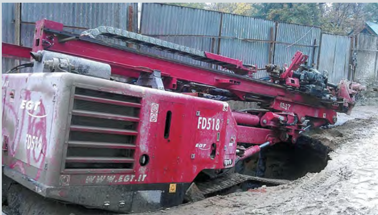
Рис. 1. Провал грунта около затопленного водогрунтовой массой ствола ВОУ
