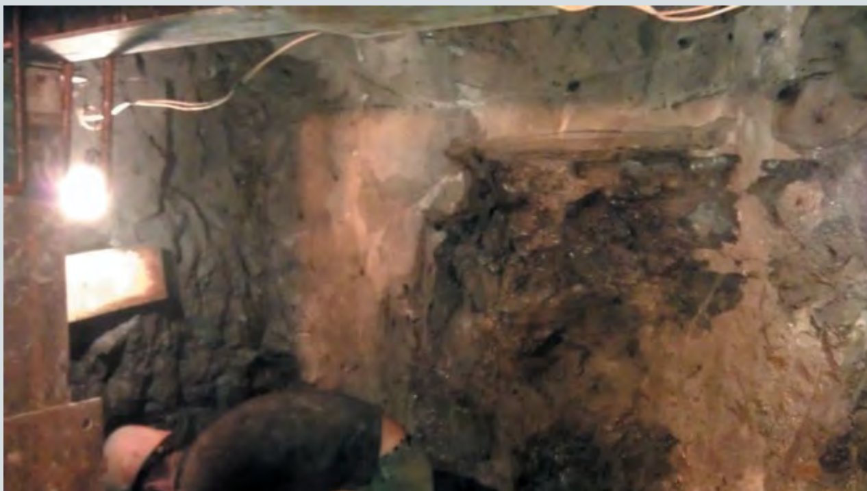
Рис. 4. Вскрытая сбойка на ПК 165+30. Темный материал по бокам — грунтобетон. Светлый материал — тампонаж заобделочного пространства. Темный материал в центре — не до конца вскрытая обделка тоннеля
