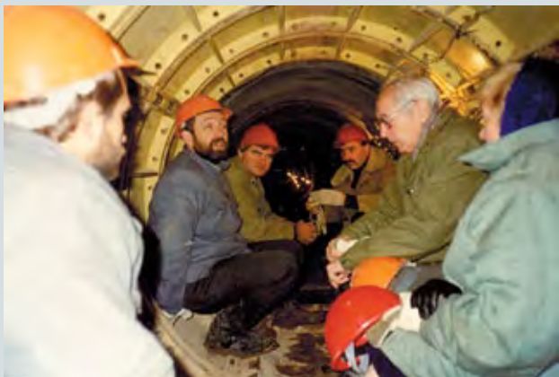
Рис. 7. Руководители «Мосинжпроекта» С.Ф. Панкина и Ю.М. Самохвалов в тоннеле с прессбетонной обделкой
