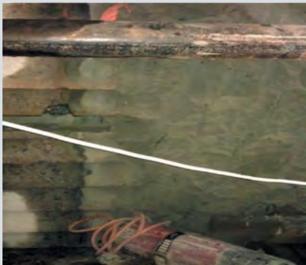
Рис. 3. Высокое качество примыкания ПФЗ к БСС ограждения котлована на ПК 165+30
