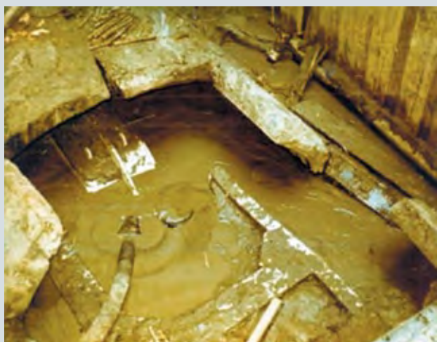
Рис. 3. Заполненный жидким грунтом тоннель за щитом на ул. Кибальчича
